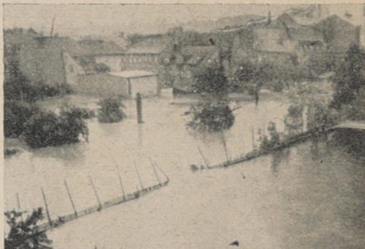
Ein Blick auf die völlig überflutete Anlage von Fortschritt Pirna während der Unwettertage im Juli
