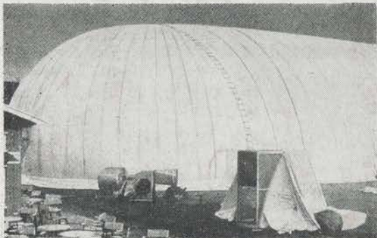
Das ist die Tennis-„Halle“ im Roevink-Tennispark von Amsterdam. Hier das aufgeblasene Nylonzelt. Rechts der Motor, der die Luft in das Zelt bläst und damit für den erforderlichen Überdruck sorgt. Fotos: Auslandsdienst
