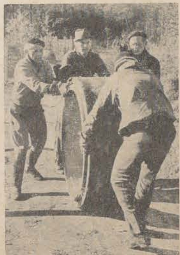
Bild oben: Das erste Baumaterial rollt per Lkw an. Darunter: Anfangs mußte das Wasser für Beton und Putz in Eimern herangeschleppt werden. Im Bild Platzmeister Schneider. Unteres Bild: Die 14 Zentner schweren Schachtringe für die Entwässerungsleitung mußten per Hand herangerollt werden. Von links sehen wir Willi Hess, Sektionsleiter Steffen Rockmann und Erich Meier.
