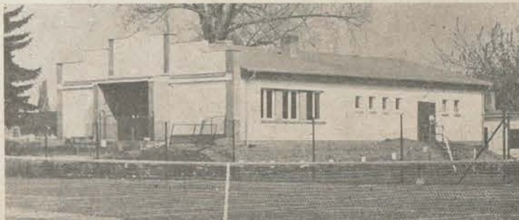
Umfangreiche Rekonstruktion der Tennisanlage Sandanger: Das neue Klubhaus ist schon übergeben
